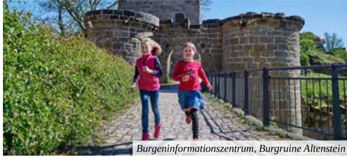
Burgeninformationszentrum, Burgruine Altenstein
